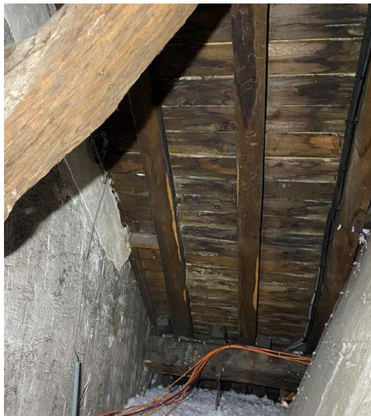
Figure 12 - Chevrons et voliges - Depuis les combles de l'aile S
