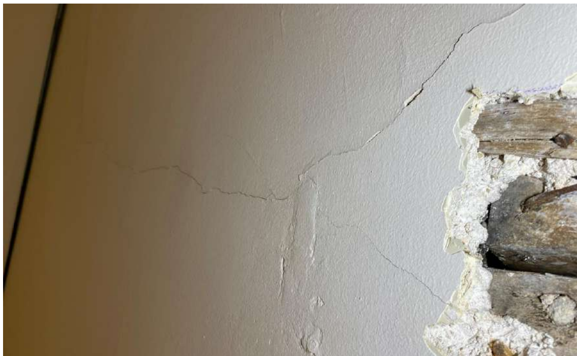
Figure 21 - Fissure zone I (centrale) - Sondage I2 - PH R+3
