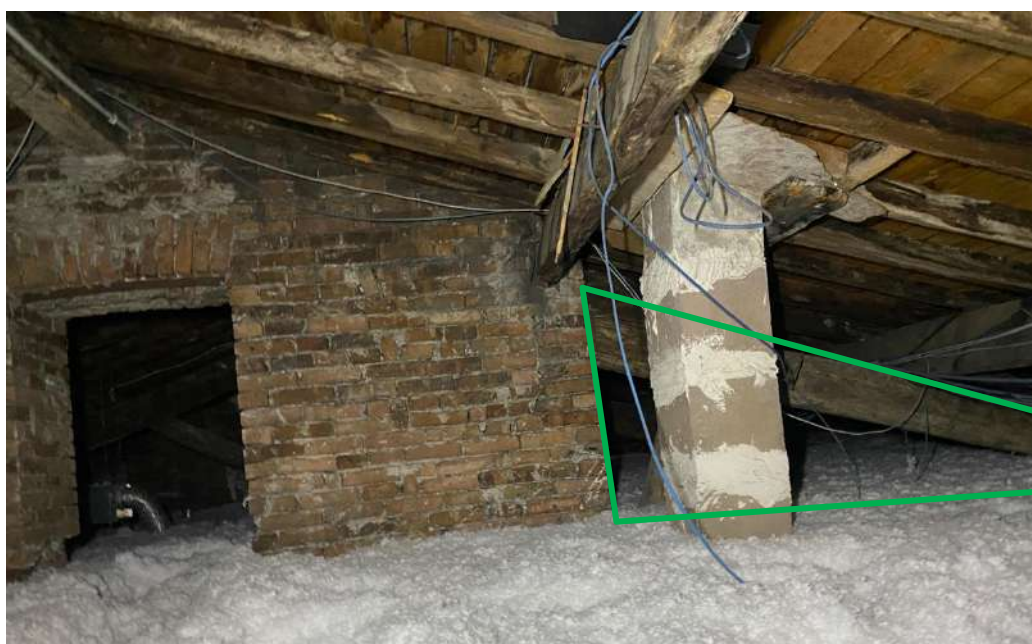
Figure 7 - Porteur composé d'une partie maçonnée et d'une ferme partiel (en vert) - Combles zone I
